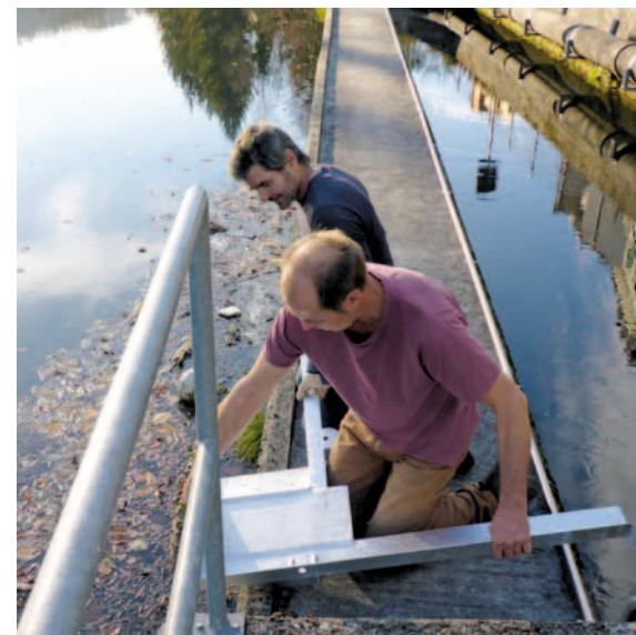
Beim Kraftwerk in Grellingen wurde für den Biber eine Rampe installiert. Nun ist der Weg für den Nager frei zur grössten Aue des Baselsbiets, der Steinrieselmatte in Brislach.
