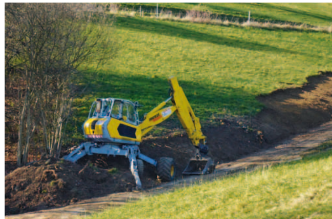
Hier wird keine Strasse gebaut, sondern ein weiterer Bach ans Licht geholt. Das Hardbächli in Zunzgen ist neben dem Hollenbächli in Oberdorf und dem Bombergbächli in Ziefen das dritte Kleingewässer, welches 2015 ausgedolt wurde. Damit hat Pro Natura Baselland im Rahmen der Aktion Gummistiefelfeld mittlerweile 16 Bäche mit einer Gesamtlänge von 2.1 km aus den Röhren befreit.
